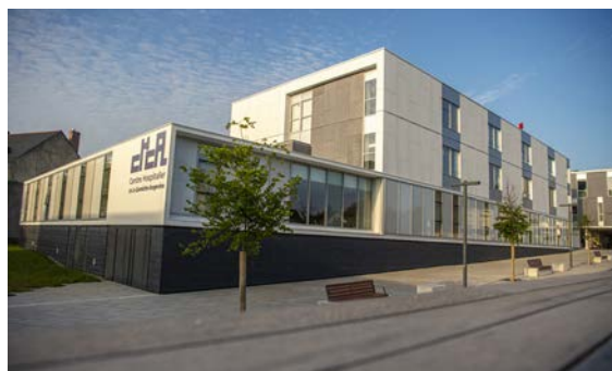
Opération au long cours, la reconstruction du centre hospitalier de la Corniche angevine (CHCA) a débuté en janvier 2018 et s'est terminée en décembre 2023. En tant qu'hôpital de proximité, le CHCA propose une offre de soins polyvalents avec 219 lits.
