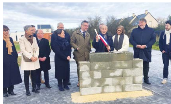
Afin d'améliorer l'offre de services de proximité en matière de santé, la commune de Cantenay-Epinard a décidé de construire une maison de santé pluridisciplinaire (MSP). La première pierre a été posée vendredi 20 décembre 2024.
