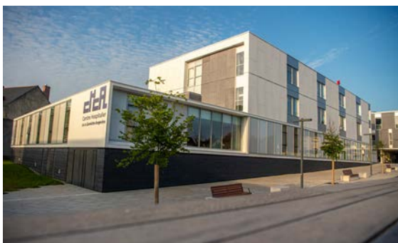
Opération au long cours, la reconstruction du centre hospitalier de la Corniche angevine (CHCA) a débuté en janvier 2018 et s'est terminée en décembre 2023. En tant qu'hôpital de proximité, le CHCA propose une offre de soins polyvalents avec 219 lits.
