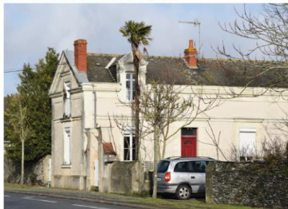
Un bâti ponctuel en pierre de taille, une couleur claire marquant le paysage, souvent accompagné de jardins arborés
