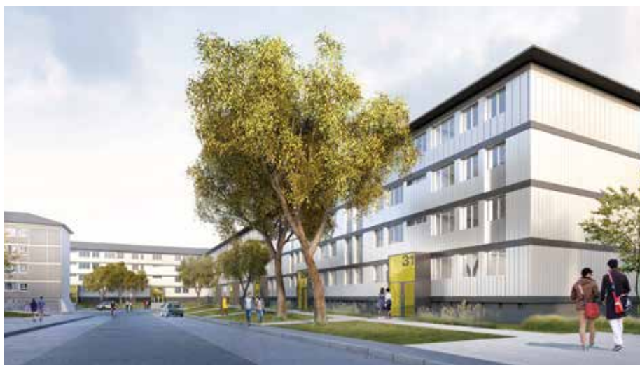
Côté Nord de la résidence, la façade sera isolée et recouverte d'un bardage en acier. Les halls d'entrée seront agrandis et équipés de portes motorisées.
