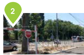
2 Travaux de sécurisation de la Route départementale 323
