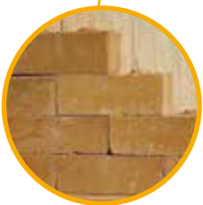
Mur brique de terre crue + isolant en fibre de bois
