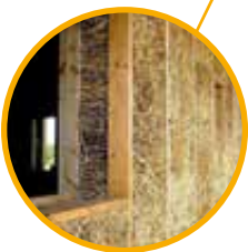
Mur ossature bois + isolant paille
