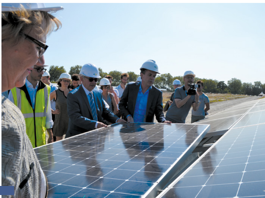
Pose du premier module de la centrale solaire aux Ponts-de-Cé
