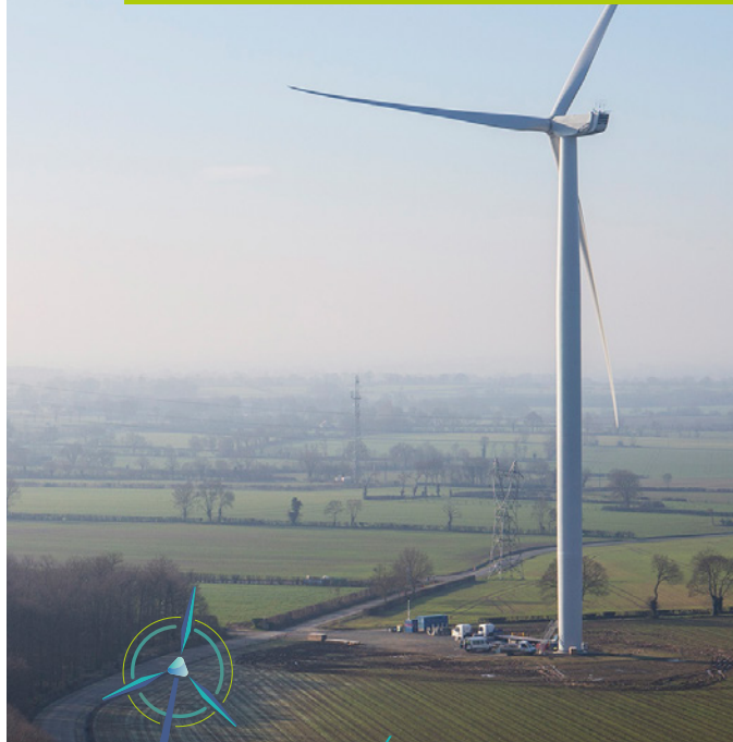
Le parc éolien de l'Hyrôme, à Chemillé-en-Anjou
